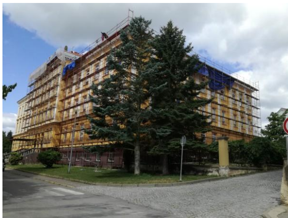
Fotografie z opravy střechy:
